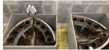
◆ 버몬트 양키 원전 RV, RVI 절단 및 포장 (2022.12) - Orano 社 Optimized Segmentation Process (최적분할공정) 적용 - 수중원격조작 bandsaws, reciprocating saws, abrasive water jet diamond wire saws, thermal cutting - 큰 조각으로 절단한 뒤 운반후 별도 장소에서 세절
