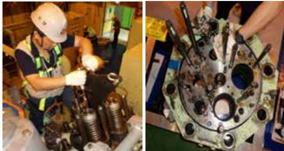
비상디젤발전기 실린더헤드 분해점검
